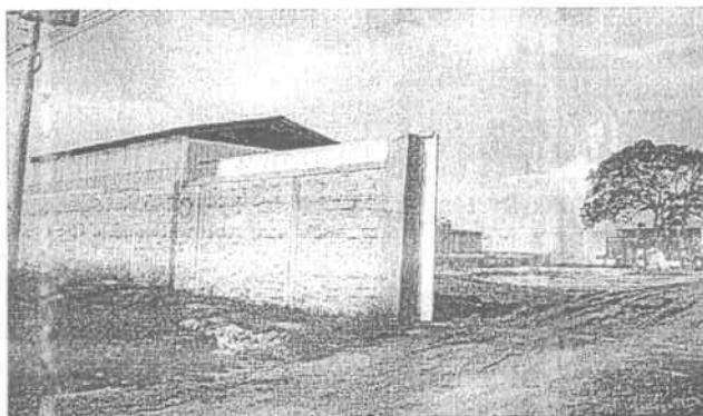
Fotografía No. 1 Facha de Bodega en construcción
